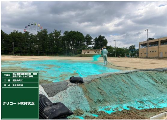
浸食防止剤散布状況
