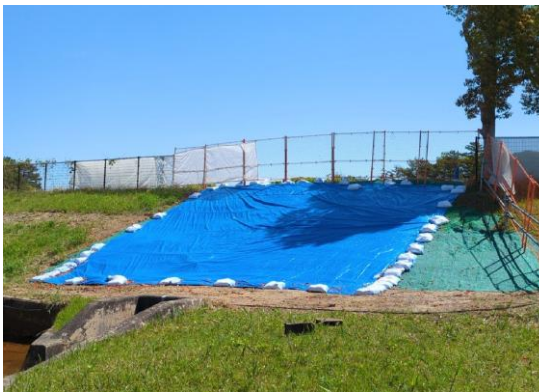
法面ブルーシート養生
