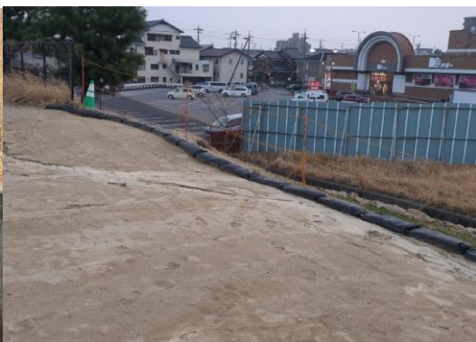
土のうによる法肩養生
