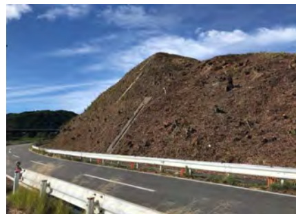
台風対策（流出防止） 雨水を確実に沈砂池に導く
