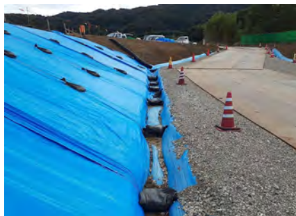
地下排水の水を場内に導水 接続初期の濁水を沈砂池に
