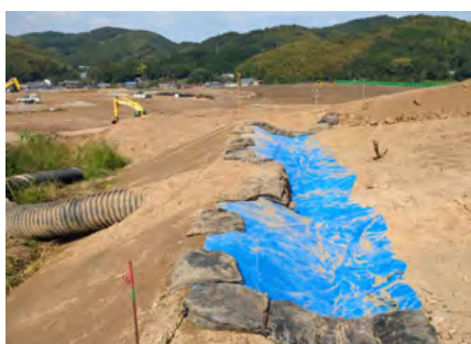
盛土途中の処理
