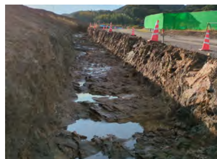
土工終盤幹線水路の切替
