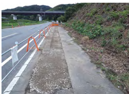
構造物撤去後 砕石敷均 砕石による濁水抑制
