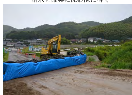
台風対策（流出防止） 雨水を確実に沈砂池に導く
