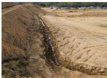
法面の水を宅盤に流さない
