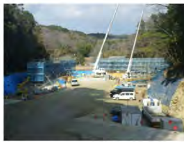
調整池3 擁壁構築
