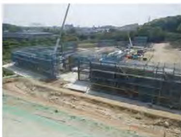
調整池 1 擁壁構築
