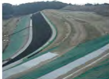
エリア1 盛土・法枠・小段排水
