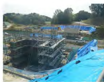
井ノ口橋 橋台構築
