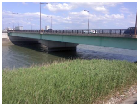
写真 128 No.41 地点 境川流末 同左、右岸堤防から平成大橋方向
