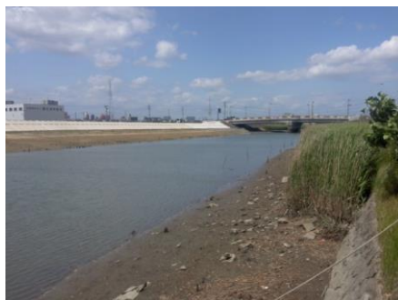
写真 130 No.39 地点 猿渡川下流 同左、上流（巡見橋）方向
