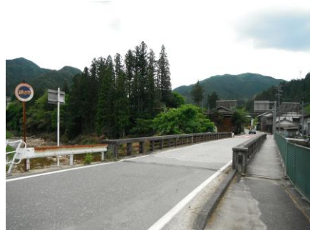
写真 27 No.5 地点 根羽川上流・小戸名川 平瀬橋 (右岸の交差点から南方向)
