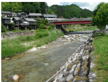
写真11 No.46 地点 飯田洞川 同上、橋下流左岸
