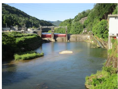
写真 35 No.56 地点 矢作川中流 百月ダム・岩倉発電所下流、岩倉橋 淡黄緑色 (フォーレル水色標準液 11 番) 糸状緑藻類が水面下の河床礫を被う。
