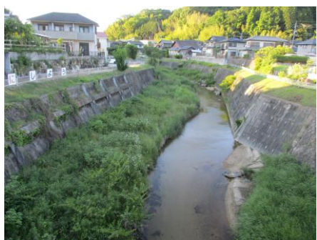
写真 61 No.59 地点 飯野川下流 広瀬橋 (上流側)
