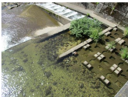
写真 33 No.48 地点 明智川下流 川ヶ渡橋直下の床固工・魚道・砂礫
