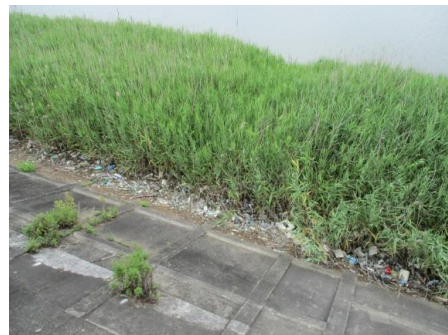
写真 130 No.41 地点 境川下流・汽水域 同左、ヨシ帯と堤防間に漂着ゴミが多量に堆積。
