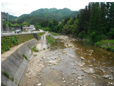
写真 15 No.5 地点 根羽川上流 平瀬橋 (上流方向)
