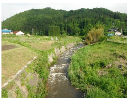
写真 28 No.30 地点 段戸川上流 大橋、上流方向 (降雨後)
