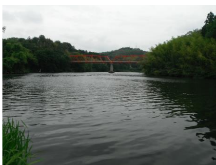
写真 19 No.34 地点 矢作川中流 竜宮橋 (左岸から下流方向)
