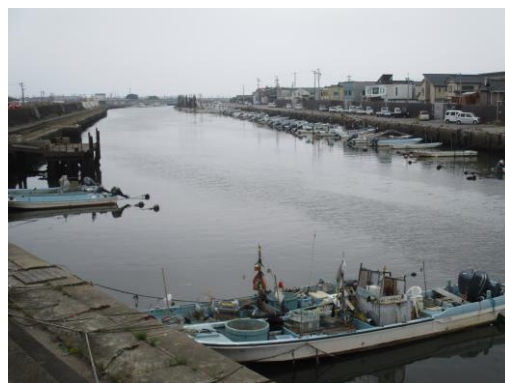
写真 122 No.23 地点 一色排水路 河口入江 一色漁港 (6/10)
