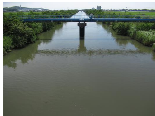
写真 100 No.17 地点 広田川 岡島橋 (下流方向、6/22)
