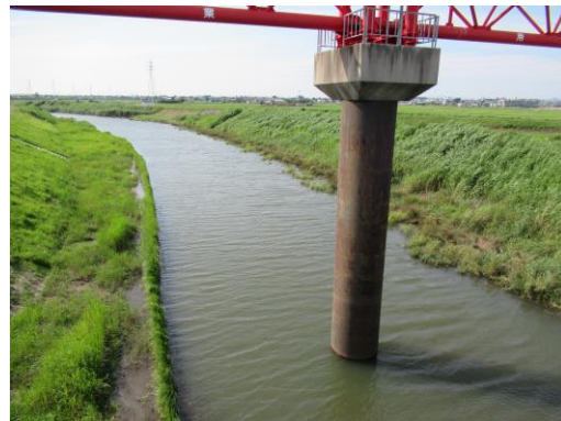
写真 98 No.51 地点 広田川 中吉橋 (下流方向、6/22)
