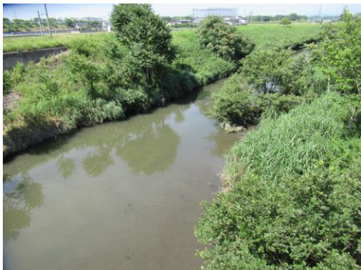
写真 101 No.18 地点 安藤川 江原小橋 (左岸から上流方向、6/22)
