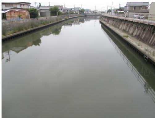
写真 118 No.23 地点 一色排水路 間浜橋 (前野排水機場のの上流、内陸側、6/10)
