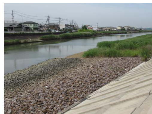
写真 110 No.39 地点 猿渡川 巡見橋（右岸下流、6/22）
