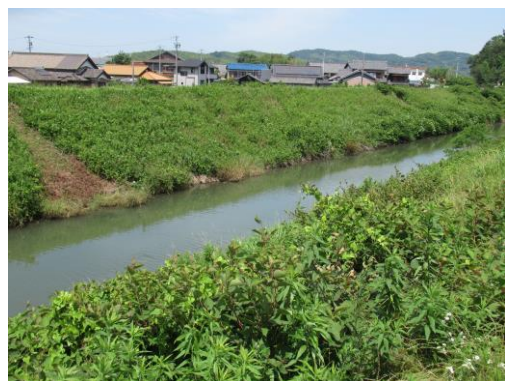
写真 103 No.19 地点 須美川 宮下橋 (左岸から上流方向、6/22)
