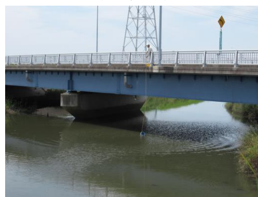
写真 116 No.21 地点 北浜川 刈宿橋 (6/22)
