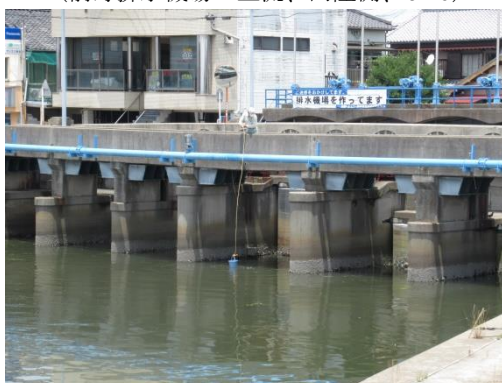
写真 120 No.23 地点 一色排水路 間浜橋 (防潮水門、6/22)
