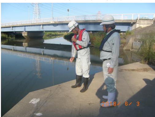
写真 115 No.21 地点 北浜川 刈宿橋 (6/3)
