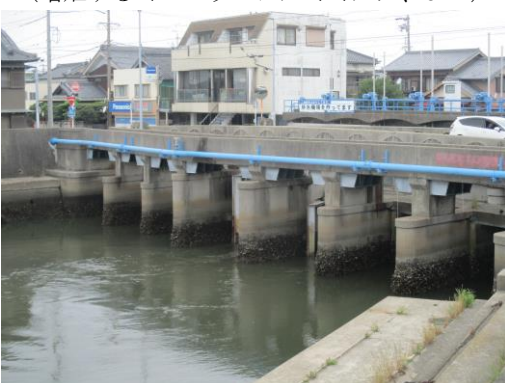
写真 119 No.23 地点 一色排水路 間浜橋 (防潮水門、6/10)
