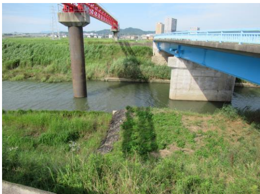
写真 97 No.51 地点 広田川 中吉橋 (左岸堤防から右岸・北方向、6/22)
