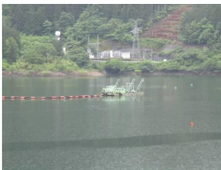
写真 32 同左、浚渫船 (東海豪雨でダム湖に溜まった土砂を取り除く作業が進められているが、浚渫した土砂の処理も課題になっている。)
