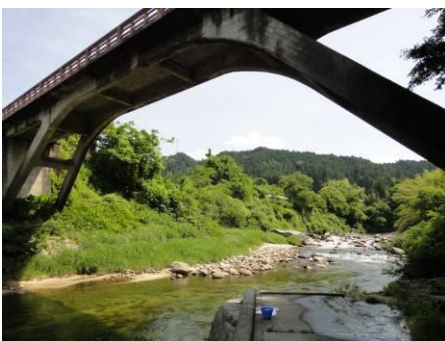
写真 29 No.4 地点 根羽川下流 国界橋
