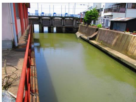
写真 111 No.23 地点 一色排水路 間浜橋下の樋門は観音戸 (マイターゲート)。河川水と潮位の水圧に反応して自動的に開閉する。調査時は下げ潮時で水路の水が流出中。
