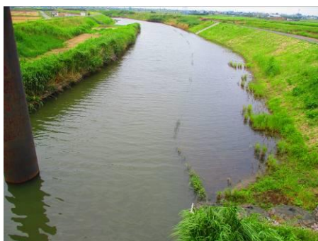
写真 99 No.17 地点 広田川中流 中吉橋、中央（下流側） 右岸 河川工事（前年度）後
