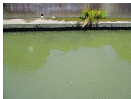
写真 110 No.23 地点 一色排水路流末 同左 (外観: 藍藻類の緑に底泥・黒が混った暗緑色)
