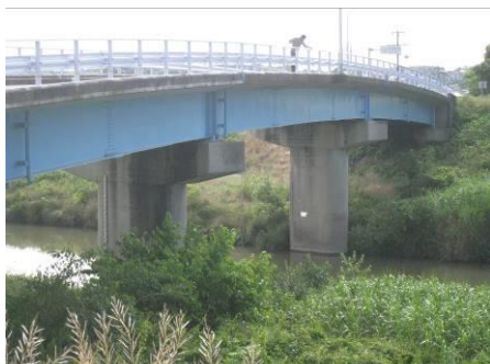
写真 117 No.28 地点 境川 8K2 付近 国道 23 号 (知立ハイパス) 橋、採水
