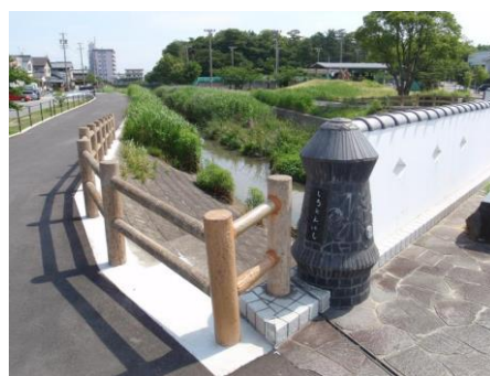
写真 100 No.22 地点 二の沢川下流 白妙橋、上流側（右岸から）
