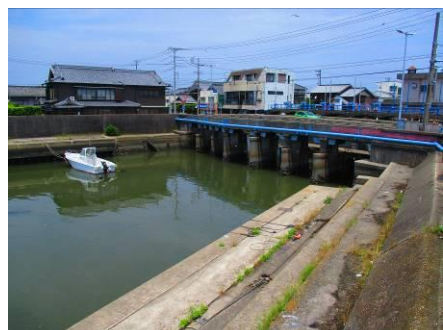
写真 109 No.23 地点 一色排水路流末 同右上、間浜橋、排水樋門・前野排水機場
