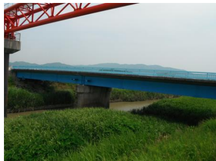
写真 98 No.51 地点 広田川中流 中吉橋 (左岸堤防から上流方向)
