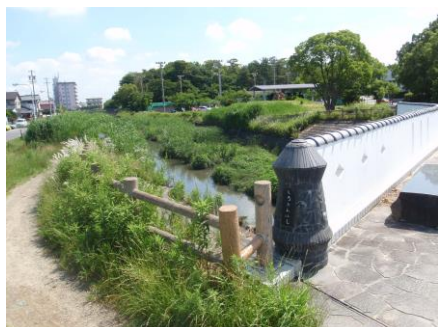
写真 111 No.22 地点 二の沢川下流 白妙橋下流右岸側（上流方向）
