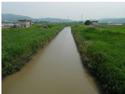
写真 97 No.51 地点 広田川中流 中吉橋、中央 (上流側)、同右上から懸濁化
