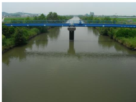
写真 100 No.17 地点 広田川下流 岡島橋、中央 (下流側)
