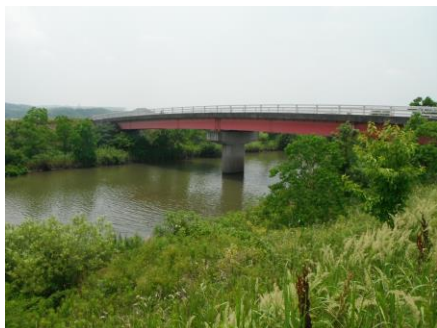
写真 101 No.17 地点 広田川下流 堤外植生 (右岸堤防から岡島橋方向) 水際から斜面上にノイバラ (バラ科、落葉性のつる性 低木)、多年草本類が繁茂する。
