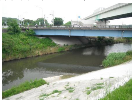
写真 103 No.18 地点 安藤川下流 江原小橋 (左岸下流側から)
