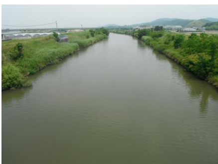
写真 99 No.17 地点 広田川下流 岡島橋、中央 (上流側)
