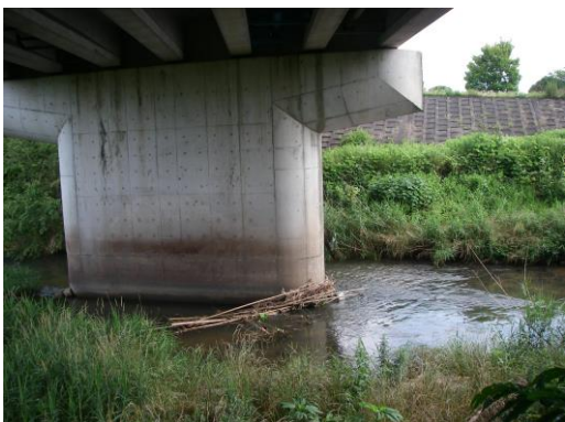
写真 73 No.12 地点 青木川 青木橋 (左岸から右岸・北方向、6/19)
