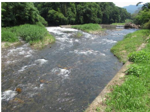
写真 81 No.38 地点 乙川水系 男川 (左岸から上流の夏山川合流点方向、6/25)
