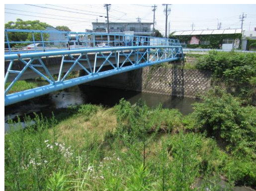
写真 90 No.50 地点 乙川水系 山綱川 美岡橋 (岸边・河道に雑草・樹木が繁茂、6/25)
