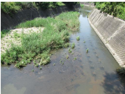
写真 69 No.No.62 地点 家下川、家下川樋門(直上、6/25)
