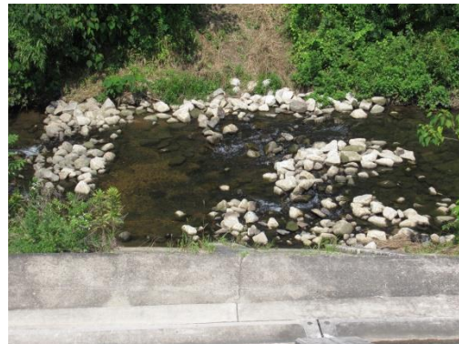
写真 66 No.61 地点 加茂川、加茂川水門 (同左下流、玉石で緩勾配に構築された堰部、6/25)
