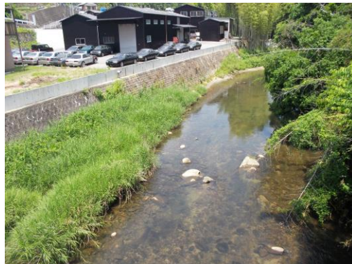
写真 86 No.14 地点 乙川上流 築野橋 (上流方向、6/3)
