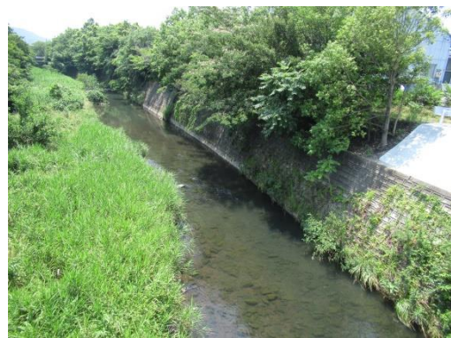
写真 88 No.50 地点 乙川水系 山綱川 美岡橋 (橋中央から上流方向、6/25)
