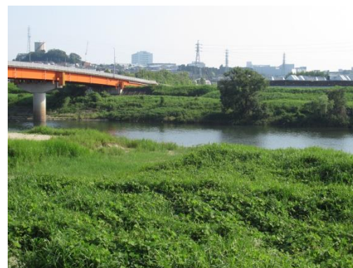
写真 68 No.34 地点 矢作川中流 竜宮橋 (左岸堤防から西方の右岸堤防方向、6/25)
