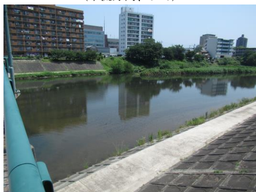
写真 93 No.15 地点 乙川下流 吹矢橋 (左岸から上流・東方向、6/25)
