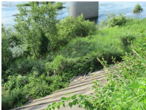
写真 77 No.36 地点 矢作川中流 矢作橋 左岸堤防際 (ヤナギ属・ツルヨシ、6/22)
