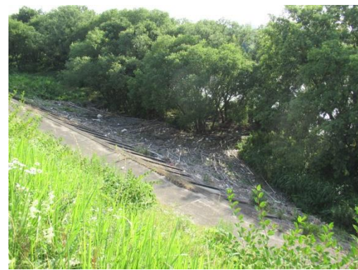
写真 78 No.36 地点 矢作川中流 矢作橋 左岸河畔林 (堤防と高木林の間に塵芥が堆積、6/22)
