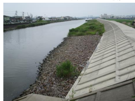
写真 126 No.39 地点 猿渡川下流・汽水域 同左、右岸堤防（コンクリート防護）、碎石床固低水護岸
