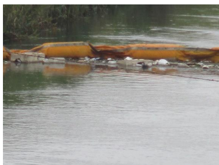
写真 109 No.21 地点 北浜川下流・汽水域 同右上、シルトフェンスに捕捉された流下ゴミ
