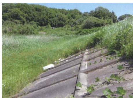
写真 99 No.34 地点 矢作川中流 竜宮橋、左岸側から上流方向 (草本植生と河畔林)
