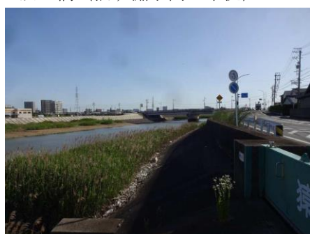
写真 123 No.39 地点 猿渡川下流・汽水域 巡見橋、左岸側から上流方向、ヨシ帯 ヨシ帯と堤防間に漂着ゴミが多量に堆積。
