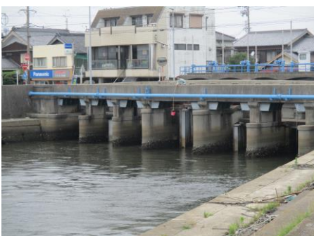
写真 111 No.23 地点 一色排水路・汽水域 間浜橋・水門 (前野排水機場)、採水 6/29 13:25
