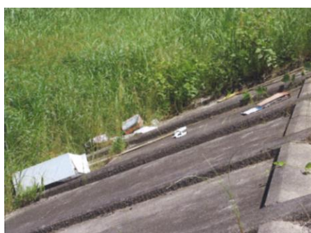
写真 100 No.34 地点 矢作川中流 同左 (拡大)、堤防下 (法尻・低水敷) の投棄ゴミ
