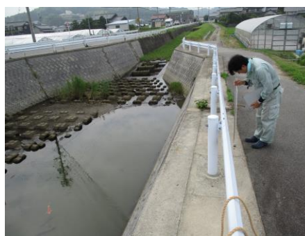
写真 116 No.24 地点 矢崎川下流・汽水域 同左、床固・落差工 (擬石・緩傾斜) 砂礫質の河床、透視度測定 (>100cm)
