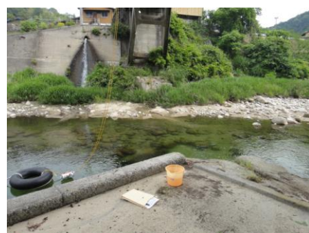
写真16 No.4 地点 根羽川下流 同左 (測定)
