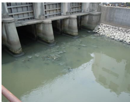
写真 53 No.23 地点 一色排水路下流 間浜橋
