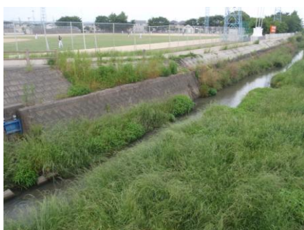
写真 51 No.22 地点 二の沢川下流 白妙橋
