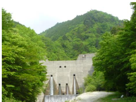
写真1 No.1地点 柳川 矢作川源流の碑 上流側
