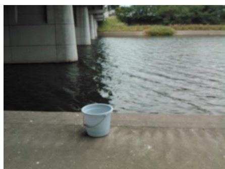
写真 43 No.15 地点 乙川下流 明代橋
