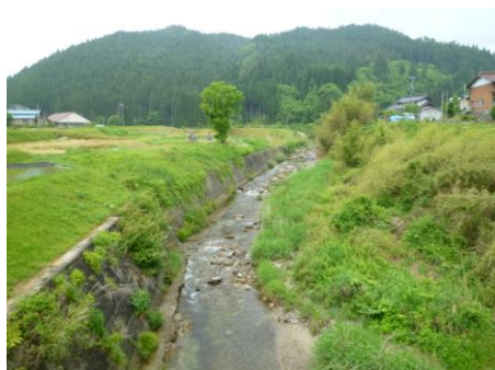
写真 65 No.31 地点 段戸川上流 大橋 (大多賀町) 上流側
