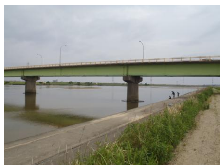
写真 31 No.8 地点 矢作川下流 棚尾橋 (左岸にて採水)
