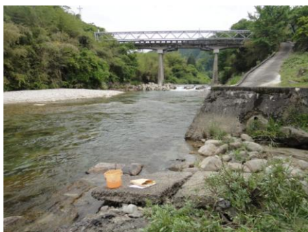
写真9 No.3 地点 上村川下流 鶺鴒 (せきれい) 橋
